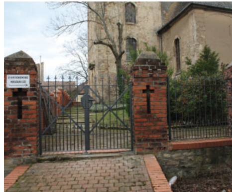
Das neue Tor zum Grundstück der Kötzschener Kirche
